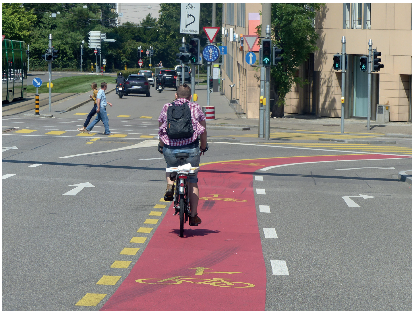
A Bâle : la bande rouge est destinée à signaler aux automobilistes qu'il s'agit d'un endroit dangereux
