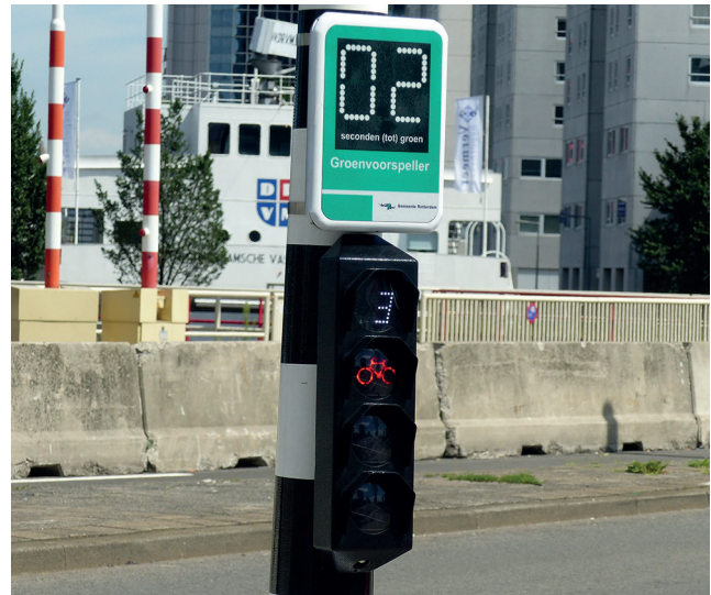
A Rotterdam, pré-annonce de feu vert pour éviter les freinages brusques des cyclistes.
