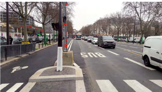
Piste cyclable en cours de réalisation av. de la porte de Clignancourt
