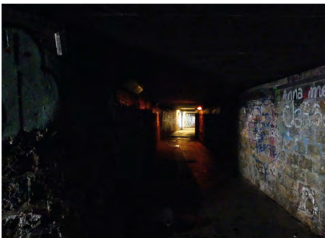
Souterrain sous l'ancienne gare Ouest-Ceinture
