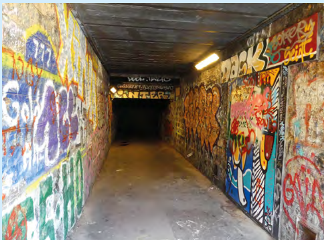
Souterrain sous la gare Ouest-Ceinture
