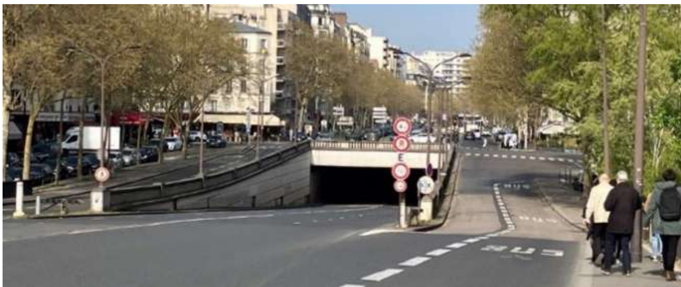
Boulevard Exelmans vu en direction de la Porte d'Auteuil ; entrée du souterrain sous l'avenue de Versailles
