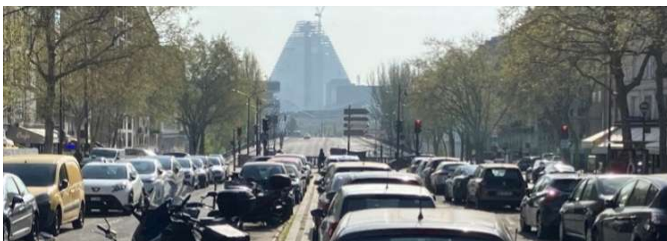
Boulevard Exelmans vu en direction du Pont du Garigliano ; entrée du souterrain sous l'avenue de Versailles
